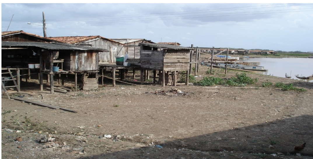
Fossas Rudimentares e tubos de água servida direto para o Rio Arari (Vila Jenipapo)
