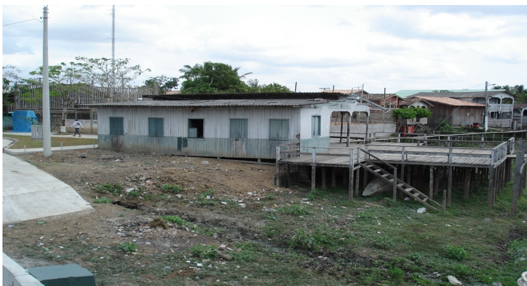
Saída dos esgotos diretamente ao Igarapé Santa Cruz pelo duto de Águas Pluviais (Santa Cruz do Arari)
